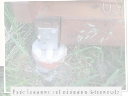
Punktfundament mit minimalem Betoneinsatz
